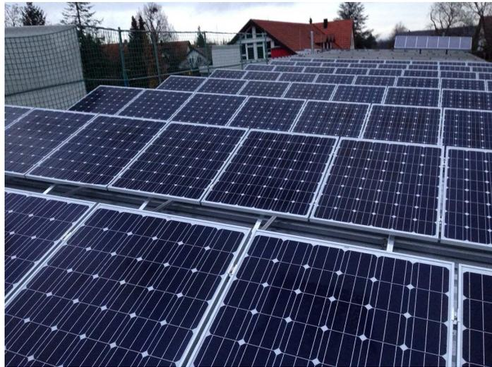
Neu errichtete PV-Anlage auf dem Dach des Bauhofs mit ca. 15 kWp
